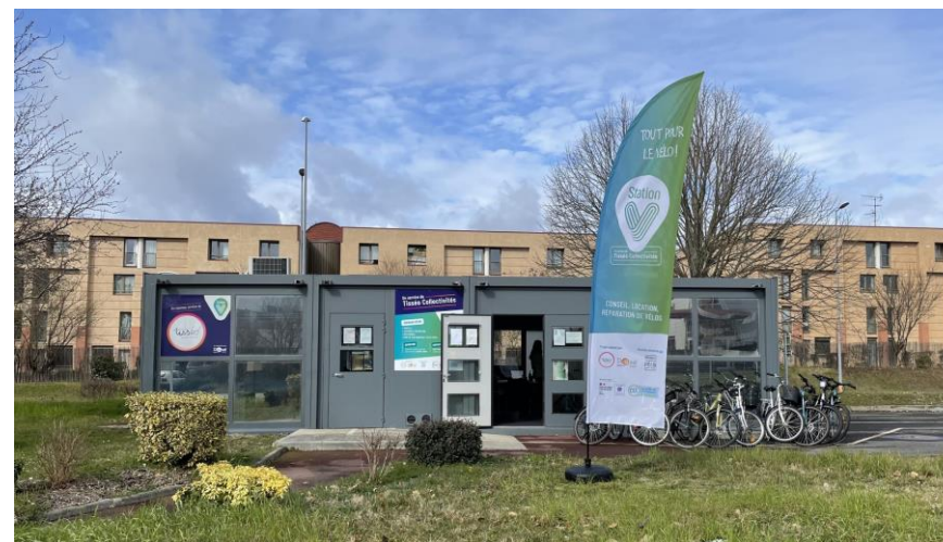
Station V de Labège ©Station V
