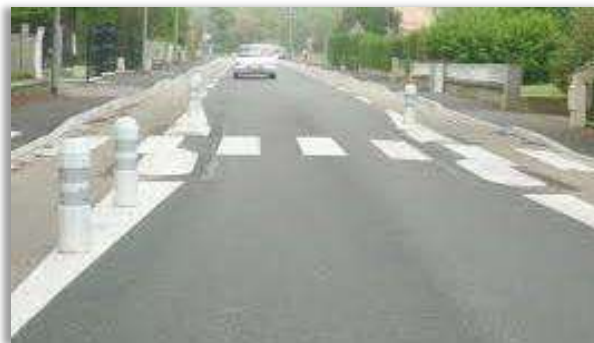
Le rappel de l'aménagement par des éléments verticaux est à proscrire dans le cas où l'ilot est trop étroit et/ou que le dispositif empiète sur la rive.
