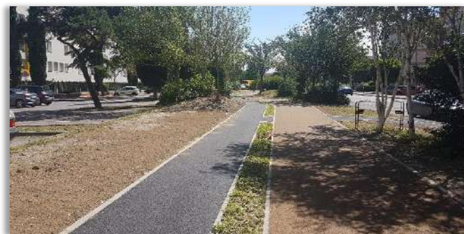
Avenue de l'Europe, Muret
