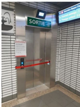
Elargissement de la porte
