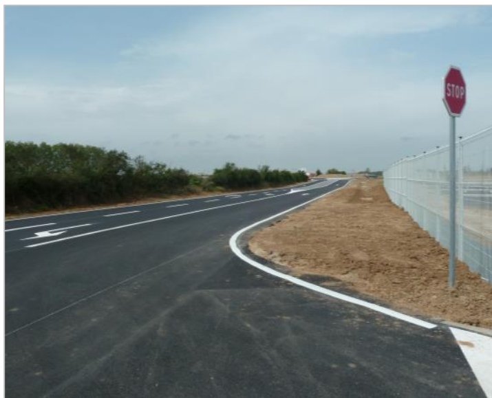
Photo 4 : Accès depuis la route de Colomiers
