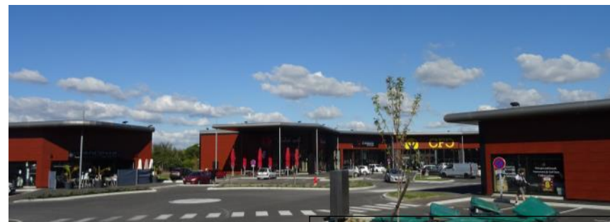
Centre commercial Les Hamats, nouvelle polarité sur le site de l'Autan Ouverture septembre 2015
