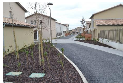
Secteur La Barthole à Castelginest
