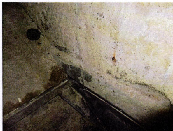
Bâche d'étanchéité Angle Sud Est
