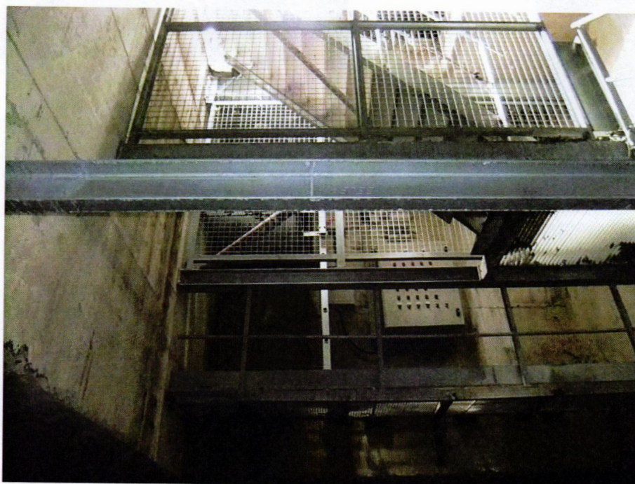
Escalier de Descente
