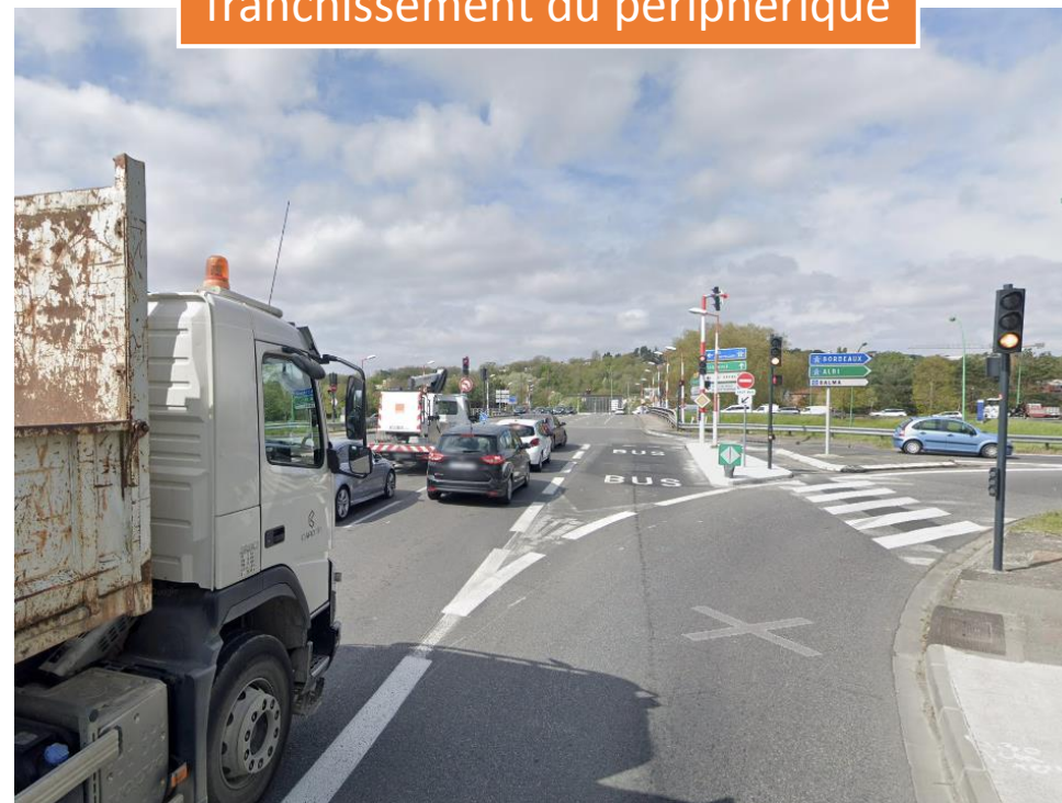
Aménagements pour le franchissement du périphérique
