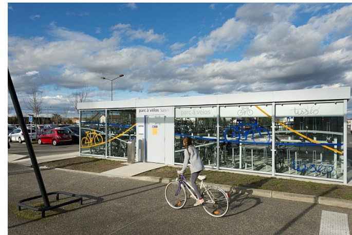
Parc à vélos avec paroi transparente, à proximité de la station de métro Ramonville
