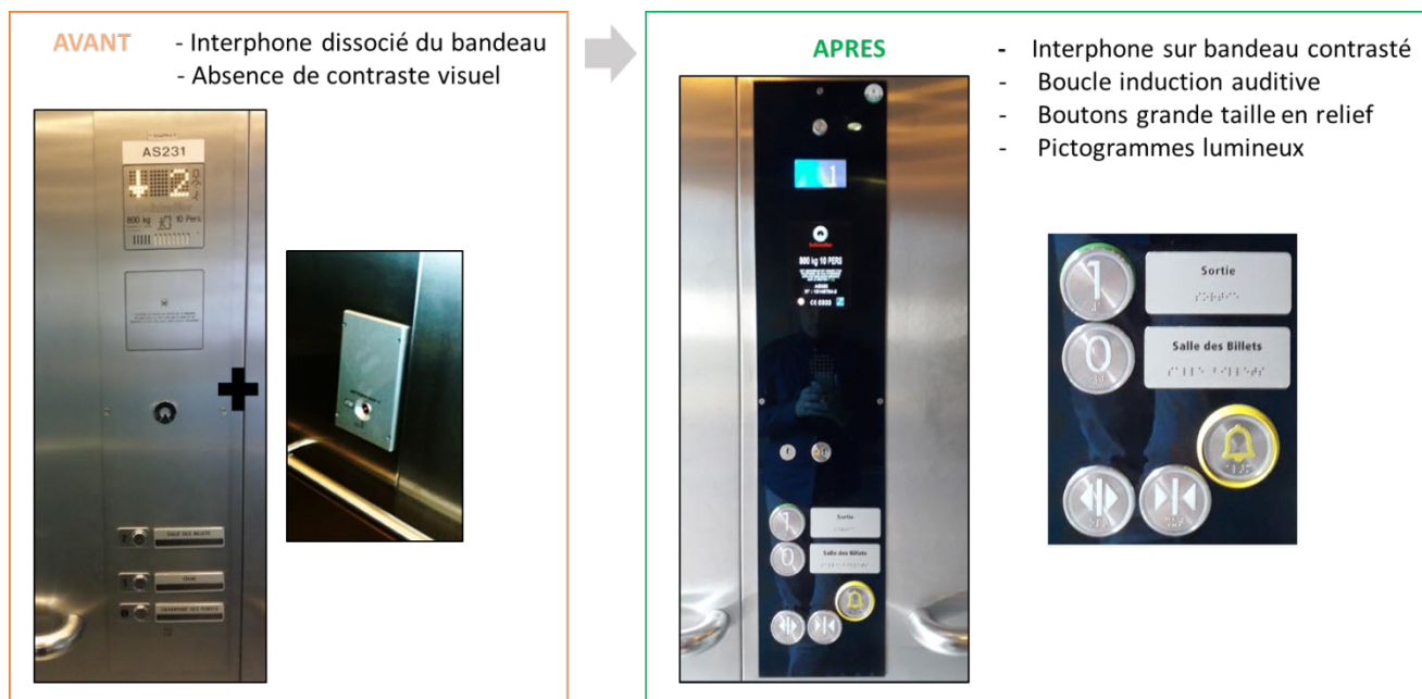
Exemple : Bandeau de commande et interphone en cabine
