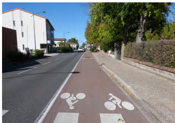
Des aménagements pour les cyclistes à conforter Route de Fronton, Aucamville
