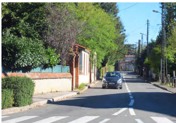
Manque d'aménagements dédiés aux piétons et aux cyclistes Chemin du moulis, Aucamville
