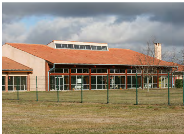
Complexe intercommunal de l'Hersain, Saint-Alban
