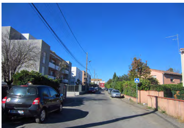
Manque d'aménagements dédiés aux piétons et aux cyclistes + stationnement sauvage Rue Edgar Degas, Toulouse
