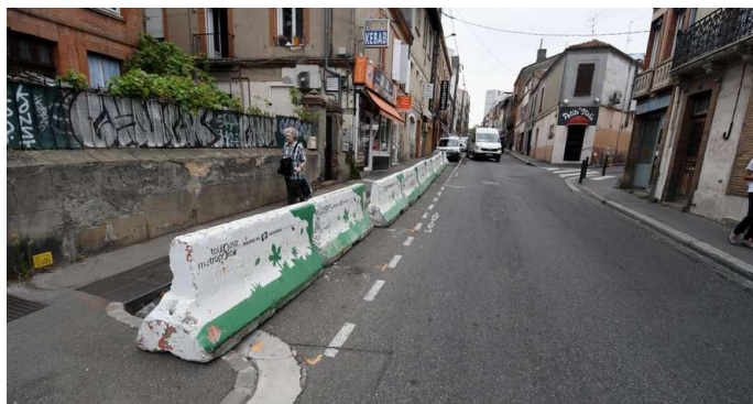
Installation de blocs en béton sur l'avenue de la Gloire à Toulouse pour faciliter la circulation piétonne - © Frédéric Charmeux
