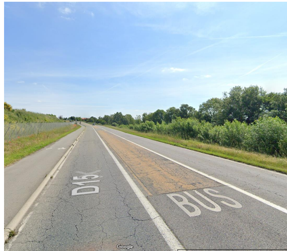
Route de Seysses (couloir bus central alterné)
