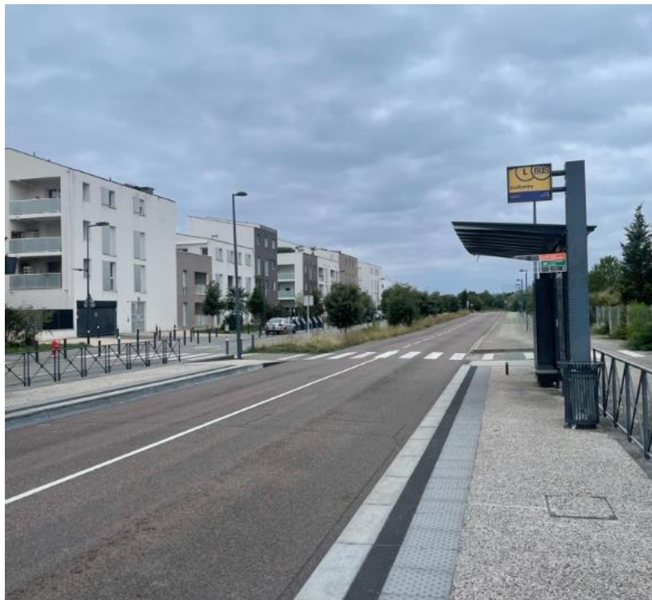
Voie du Canal Saint-Martory (site propre bus)
